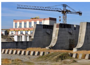
Foto: CHE și baraj deversor
