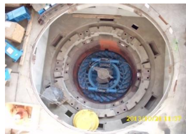
Vedere turbina parțial instalată
