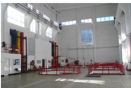
Foto: Interior CHE Nehoiășu
